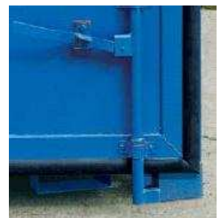
Tür mit Dichtgummi und Verriegelungsstange
